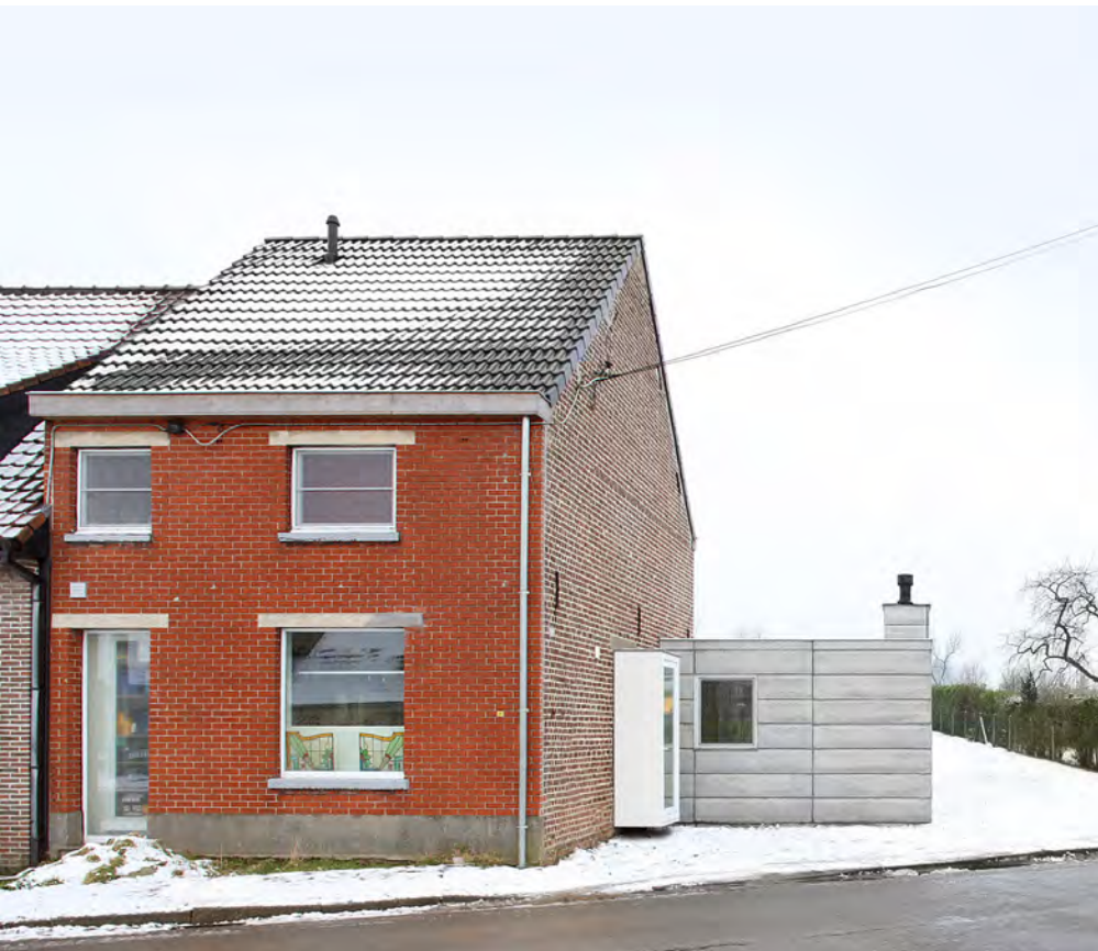
Vor- und Rückansicht Haus H. Dem typischen Backsteinbau verpassten dvvt 2008 einen Wohnzimmeranbau aus Betonplatten, die in Belgien gewöhnlich als Gartenmauern Verwendung finden (Fotos: Filip Dujardin)
