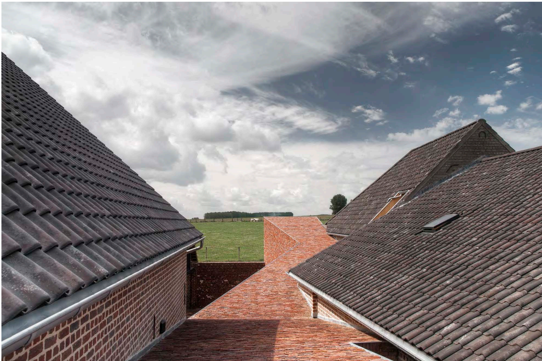
Im Lüftungsschachtähnlichen Tunnel wurden Ziegel des Bestands wiederverwertet (Foto: Philippe van Gelooven)
