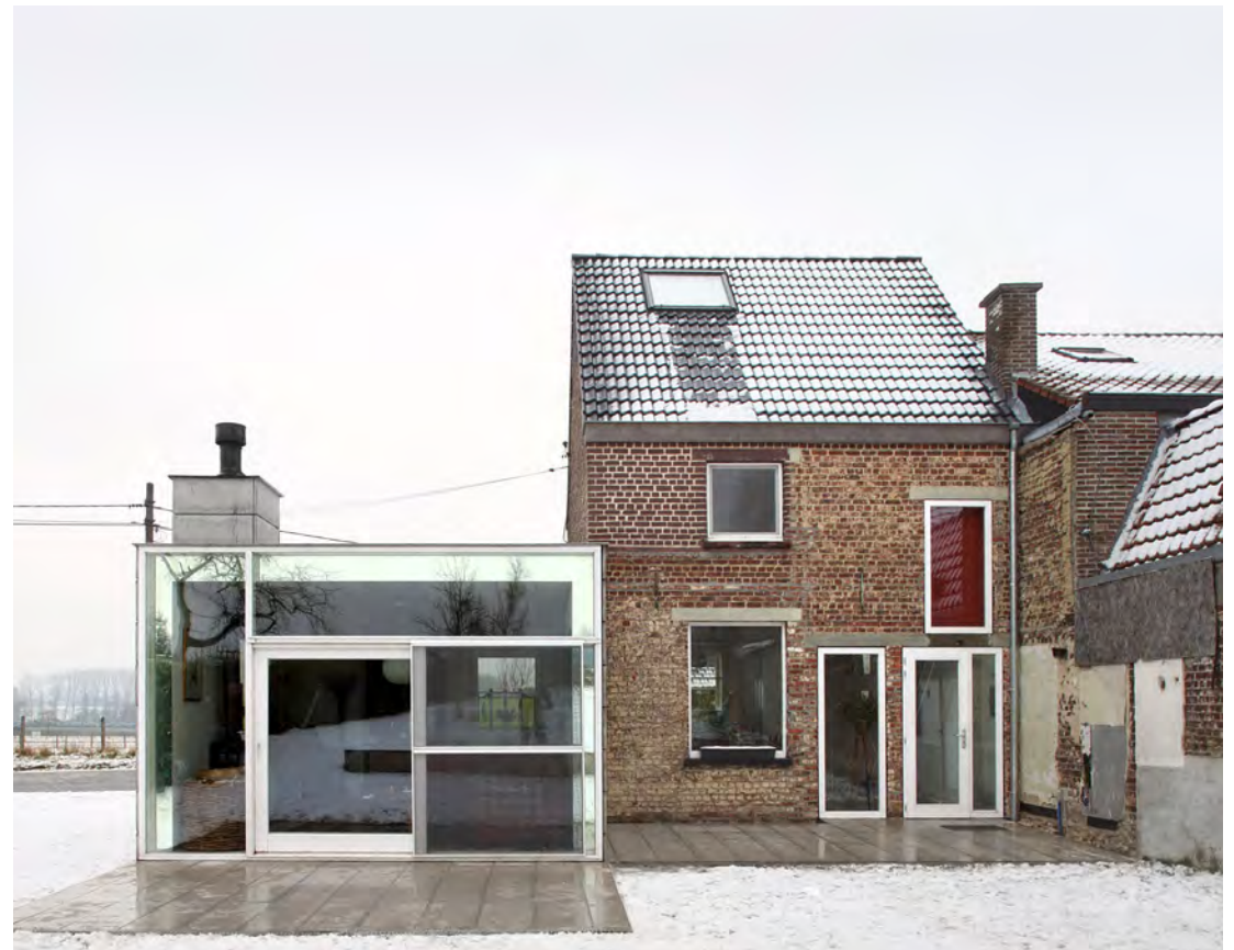
Vor- und Rückansicht Haus H. Dem typischen Backsteinbau verpassten dvvt 2008 einen Wohnzimmeranbau aus Betonplatten, die in Belgien gewöhnlich als Gartenmauern Verwendung finden (Fotos: Filip Dujardin)
