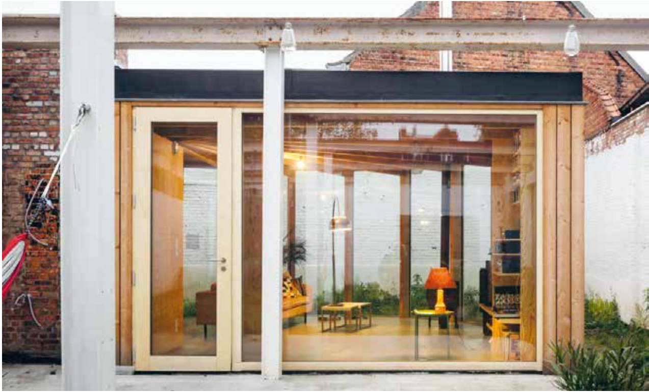
En haut, vue de l'ensemble bâti avant travaux. Ci-dessus, l'extension en charpente bois abrite les principales pièces de vie (cuisine, salle à manger et salon).
