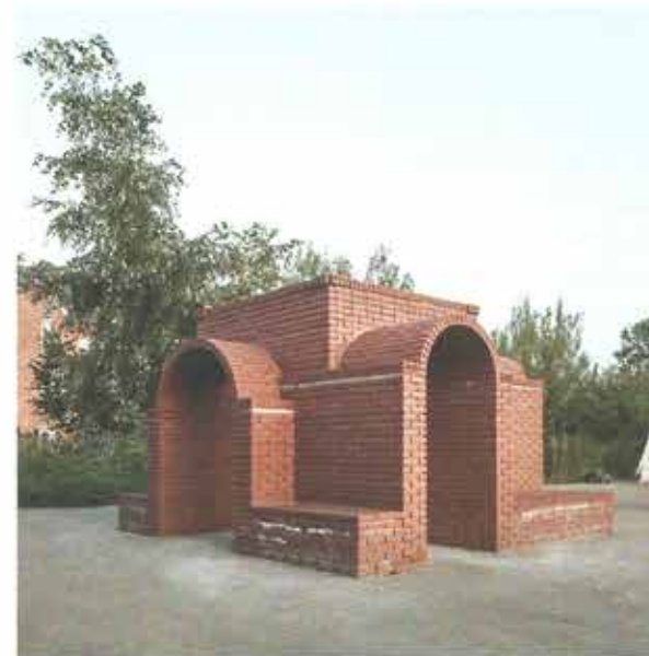
Ghent University, Bijzonder Vraagstuk (advanced topic) design theory (Maarten Van Den Driessche & Lieven Nijs – design: Tommy Messelis) – Brick Wall Ruin Pavilion, Ghent
