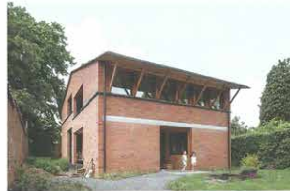
BLAF Architecten – tmEK house, Erps-Kwerps
