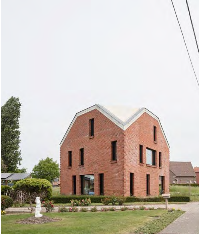
Bij deze driehoekige woning wsT in Ternat werd eerst het houtskelet opgetrokken en pas daarna een muur als bekleding (woning wsT © Stijn Bollaert)
