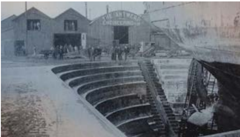
REFERENCE #2, Dry dock 4, Antwerp. Archief Gemeentelijk Havenbedrijf
