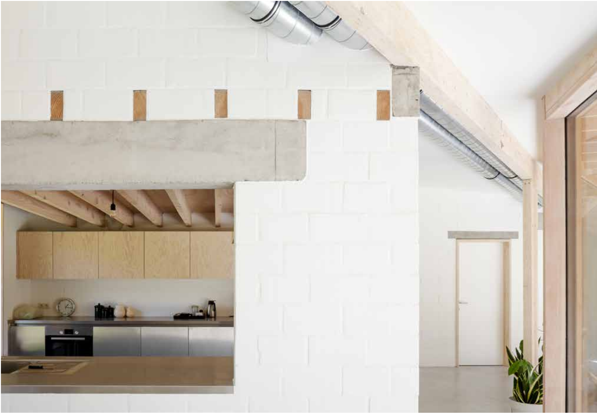
In de woning in Sint-Niklaas werd de constructie maximaal zichtbaar gelaten. Dat ‘ruwbouw is afbouw’-principe vereenvoudigt latere demontage. © Stijn Bollaert
