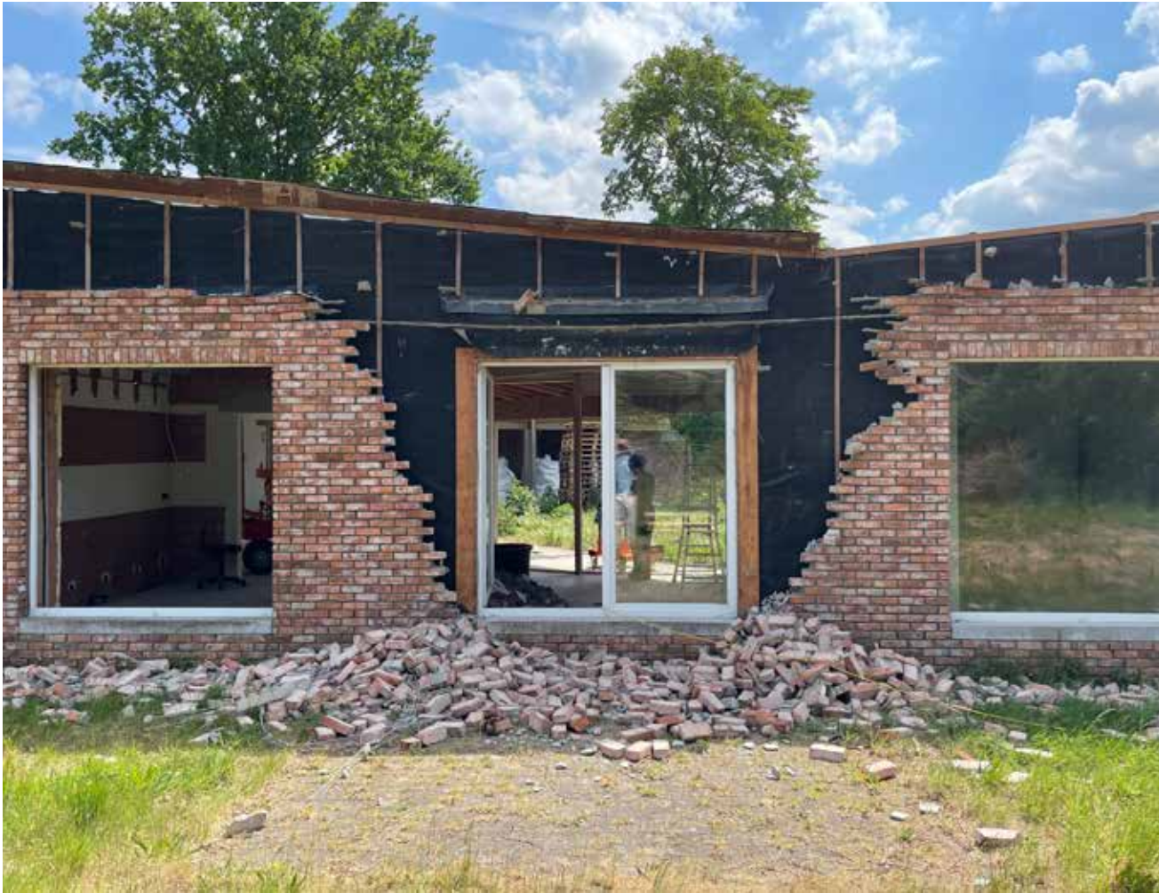
De bakstenen werden tweemaal gerecupereerd: eerst van de oorspronkelijke woning (met kalkmortel) en vervolgens van de passiefwoning (met cementmortel). “Het is een misvatting dat cementmortel de recuperatie van bakstenen in de weg staat. Je hebt meer kracht nodig maar in één slag is alles eraf”, besluit Vanden Driessche.
