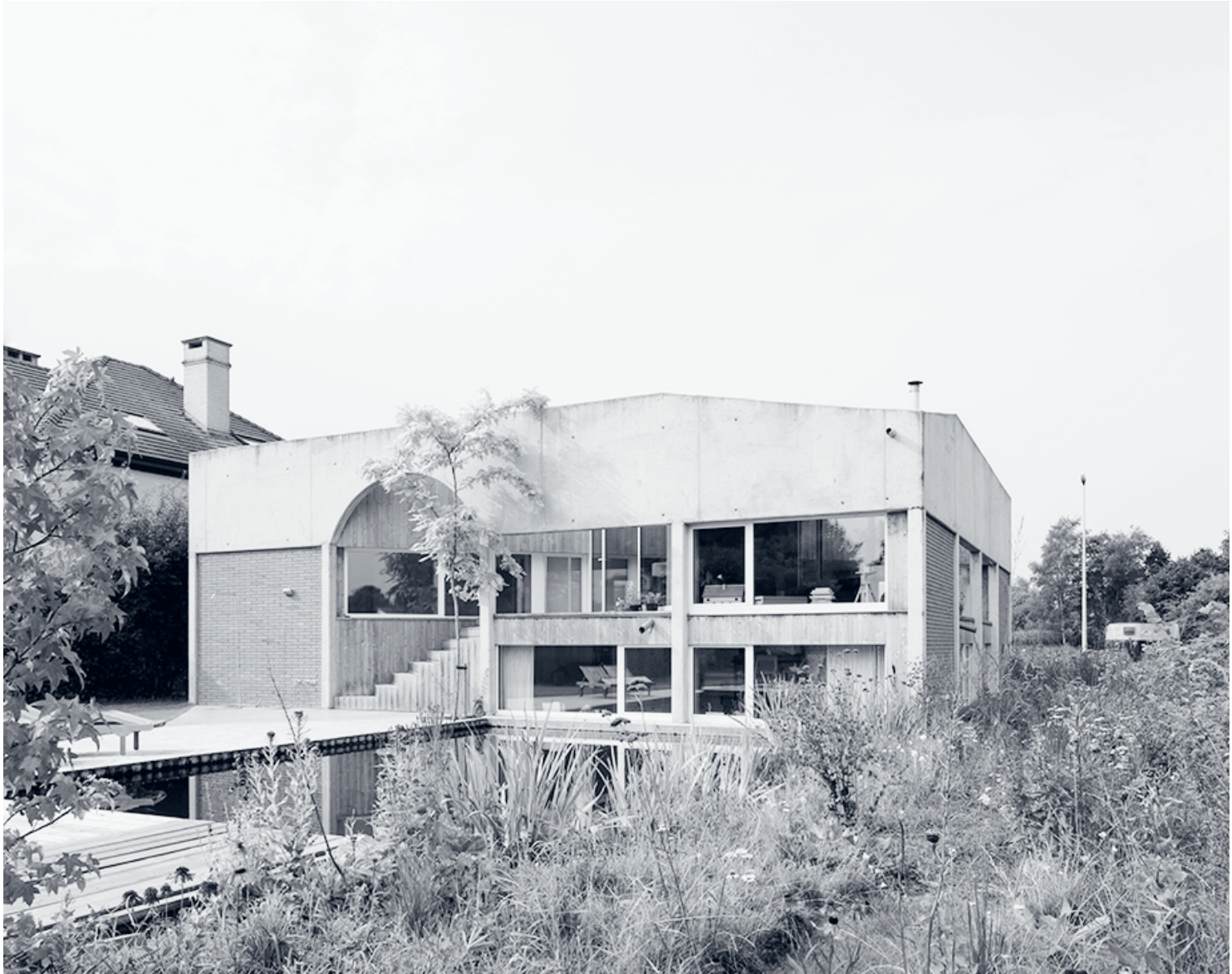
Abb. 1: Die Öffnungen in der viergeteilten Umfassungsmauer verbinden außen und innen.
