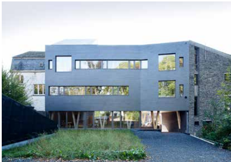
Notariskantoor in Bastenaken – David + Leblan, architectes (Malmedy) – Écorce, Bouwschil, engineering & consultancy – www.damienfranzen.be – © Foto Caroline Dethier Complex met negentien woningen en een kinderopvang in Brussel
