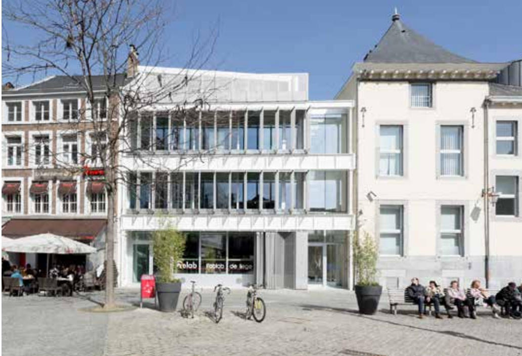
Kantoren, creatieve hub en commerciële ruimtes in Luik – arch. Pierre Hebbelinck – Écorce, ingénierie & consultance – www.damienfranz.be – © Foto Matthieu Litt – Reconversie van een industrieel gebouw met erfgoedwaarde in een stedelijke omgeving.
