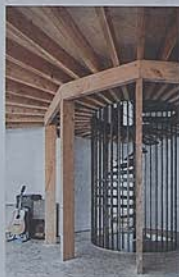
De wenteltrap in blank staal staat perfect aan op de plafondbalken.
