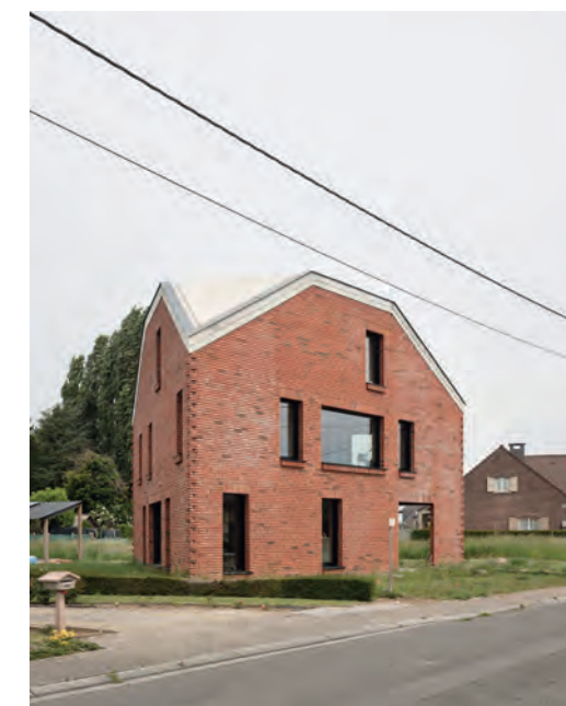
Blaf architecten, wsT House, Ternat: twee autonome structuren; een zelfdragende, structurele buitenschil in baksteen en een aparte zelfdragende binnenschil in hout.
