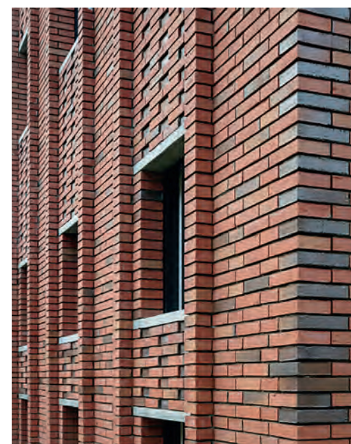
Blaf architecten, bL House, Lokeren: baksteenfaçade als autonome constructie in Big Brick metselwerk.
