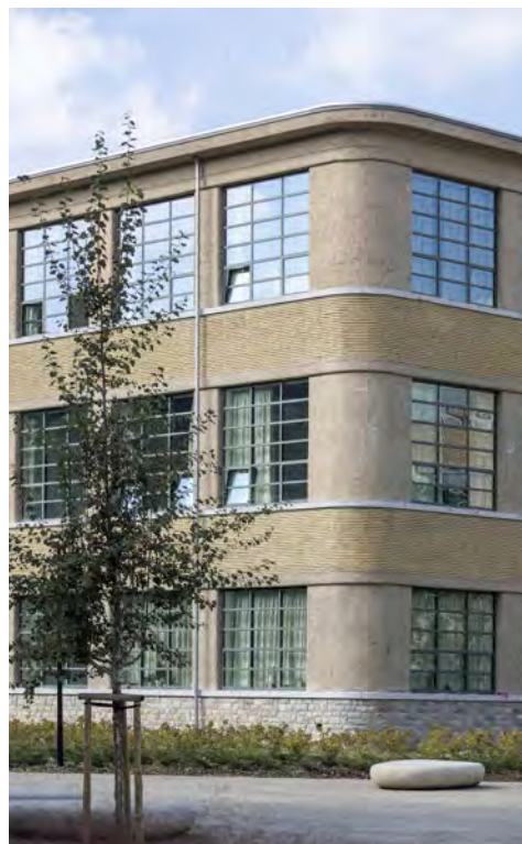
Project Arc Liège. Architect Artau architectures. (Beeld: Caroline Dethier)
