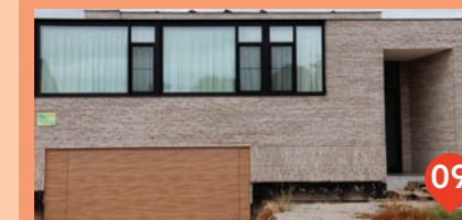
Vijverstraat 4 KACHET architects
