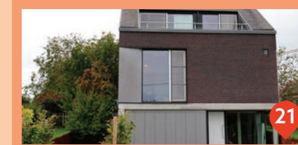
Diepestraat 2 POLO architects
